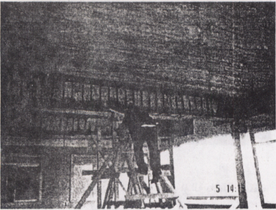
شكل ٢٥ يوضح بعض الكمرات الرئيسية بعد التدعيم
