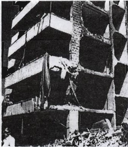
شكل رقم ٣: فقد عمود نتيجة ضغوط جانبية.
