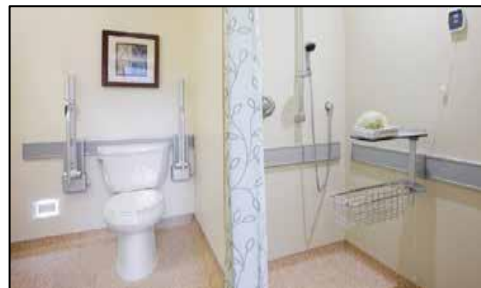
تابع صورة (14) صور مختلفة لتصميم مقابض الارتكاز في حمام المريض مابين مقبض رأسي أو مائل أو أفقي مع رأسي أو علي جانبي المراض [1]
