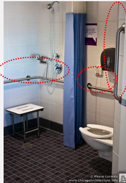
صورة (31) حمام غرفة المريض [24]
