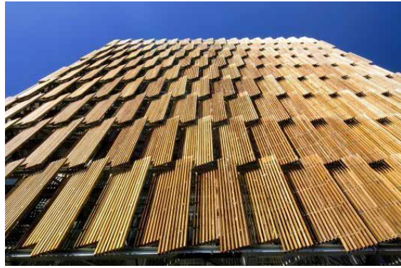
شكل (3) استخدام الواجهة المتحركة في مبنى Council House 2 بأبوظبي (6).
