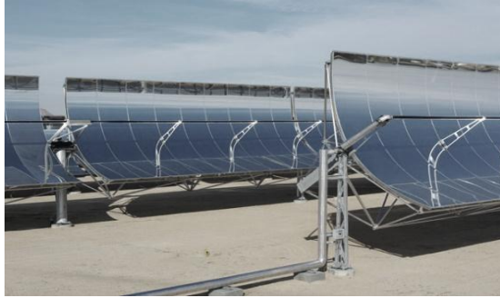
شكل (4): نظام وحدات القطع الناقص المصدر : http://www.skyfuel.com
