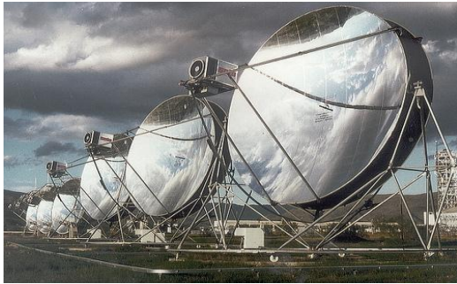
شكل (5): نظام وحدات القطع المكافئ المصدر : http://www.jc-solarhomes.com
