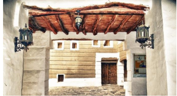
شكل رقم (5-ب) المحافظة على الأسقف بشكلها الأصلي مع إضافة وحدات إضاءة حديثة تتسم بالطابع الكلاسيكي الذي يتناسب مع طابع المكان
