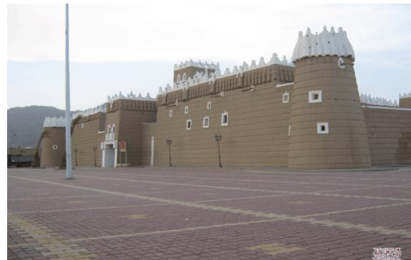
شكل رقم (4-د) تأهيل الفراغات الخارجية حول القصر بإجراء عملية تسوية وتبليط للساحات المحيطة بالقصر
