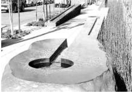
شكل 7. يوضح وحدات تجميع مياه الامطار الخارجية (20)
