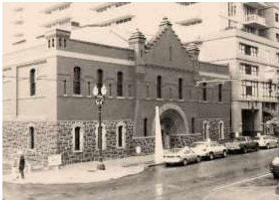
شكل 3. يوضح صورة للمبنى بعد الترميم (24)
