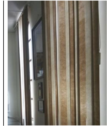
شكل (15) استخدام الستائر الشريطية للتحكم فى الإضاءة المصدر: الباحثة 22-2-2020
