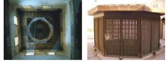
( شكل 11 ) شكل الشخشوخة وهي تعلو القاعة المصدر : نفس المرجع السابق
