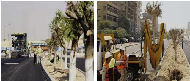
شكل (18) يوضح طريقة إزالة و نقل بعض الأشجار القديمة من مواقعها. [23].
