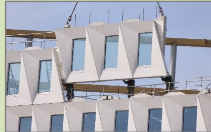
الشكل ٢٥ يوضح الفكرة العامة للبناء بالوحدات سابقة التجهيز المصدر:
