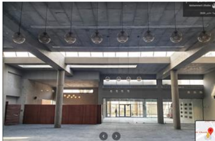
شكل رقم (٥٣): يوضح توزيع وحدات الإضاءة كنظام سقفي موفر للطاقة المستخدمة المسجد- تصوير الباحثة
