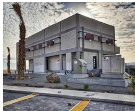
شكل رقم (٤٥): يوضح مبنى سكن الإمام المنفصل عن مبنى المسجد والمجاور له - تصوير الباحثة
