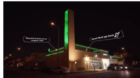
شكل رقم (١٨): يوضح الإضاءة الخارجية خارج المسجد لذوي الاحتياجات الخاصة- تصوير الباحثة
