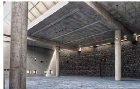
شكل رقم (٥٦): يوضح عدم استخدام مواد التشطيبات بالمسجد تصوير الباحثة
