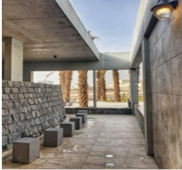
شكل رقم (٥٧): يوضح الحجر البركاني المستخدم في الميضأة تصوير الباحثة
