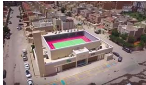
شكل رقم (٥): يوضح إبراز المسجد بين المباني السكنية المجاورة - تصوير الباحثة
