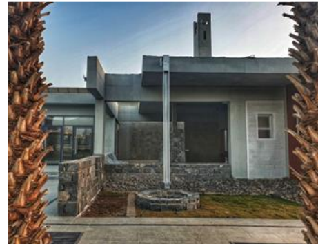
شكل رقم (٥٥): يوضح مواسير صرف مياه الأمطار المؤدية إلى الخزانات الأرضية لري الحدائق والمساحات الخضراء تصوير الباحثة
