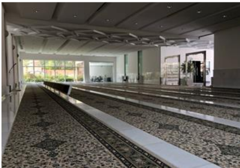
شكل رقم (٢٨): يوضح تشكيلات الأسقف الجبسة المستخدمة في المصلي للمسجد - تصوير الباحثة
