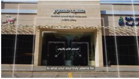
شكل رقم (٢٠): يوضح تصميم الأبواب الخارجية بارتفاع ٢٠ سم ليتناسب مع كبار السن وذوي الاحتياجات الخاصة - تصوير الباحثة
