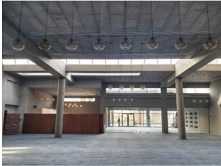
شكل رقم (٥٨): يوضح الهيكل الإنشائي الصريح والبسيط المستخدم في المسجد - تصوير الباحثة
