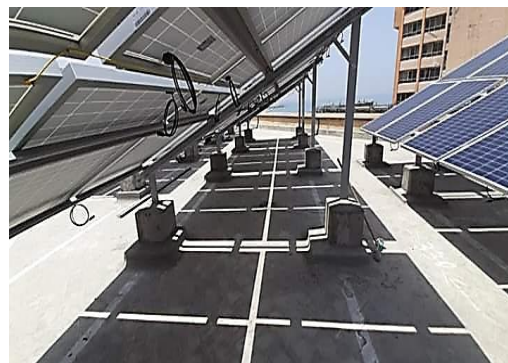
شكل (37) يوضح المسافات البينييه بين الألواح وبعضها وركائز التثبيت: تصوير الباحث لمشروع قائم بمبنى محافظه دمياط: تصوير الباحث
