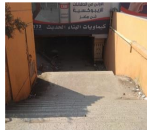
شكل (26) صورة توضح مدخل النفق من الجانب الآخر - المصدر الباحث
