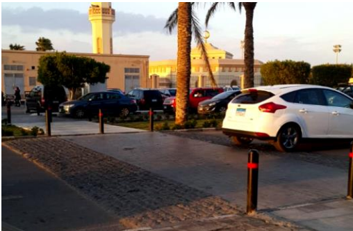
شكل (4) يوضح معبر مشاة سطحي بمستوى الرصيف في صورة مطب. [2]
