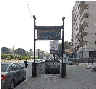
شكل (22) صورة توضح مدخل نفق المشاة بالطالبية - المصدر الباحث
