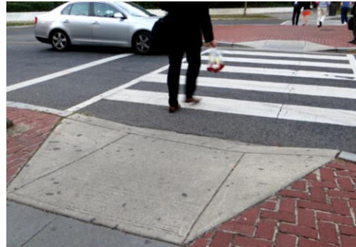
شكل (5) يوضح منحدر البردورة لمعبر مشاة سطحي بمستوى الطريق. [2]
