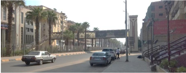
شكل (15) صورة توضح كوبري مشاة المطبعة بشارع الهرم - المصدر الباحث
