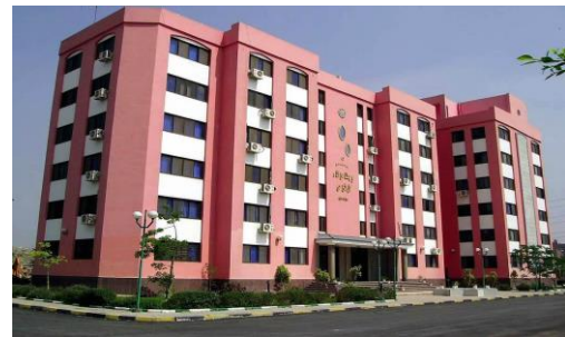
شكل رقم (٥): يوضح مبنى شركة مياه الدقهلية المصدر: الباحثون زيارات ميدانية
