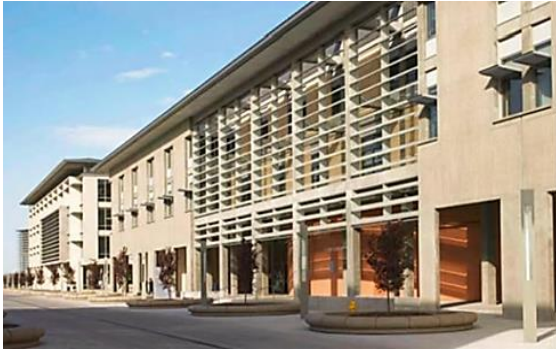
شكل (8) يوضح الكاسرات الشمسية في الواجهة بمبنى جامعة كاليفورنيا (ميرسيد)، (Net Zero Building, 2019)
