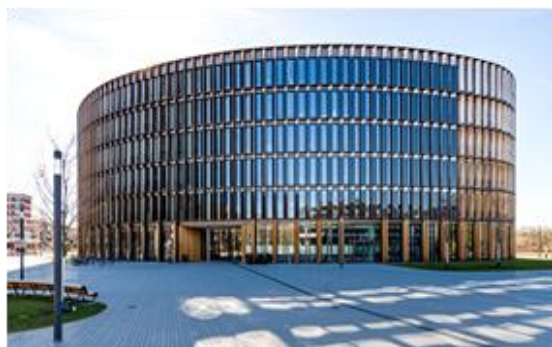
شكل (25) توضيح لكيفية استخدام أدوات محاكاة المبنى، ("Solar modules for new City Hall of Freiburg," 2016)
