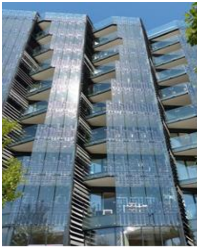
شكل (24) مبنى بفريسا الواجهة الجنوبية ألواح شمسية (.Fixing of solar panels, Hikari," n.d")
