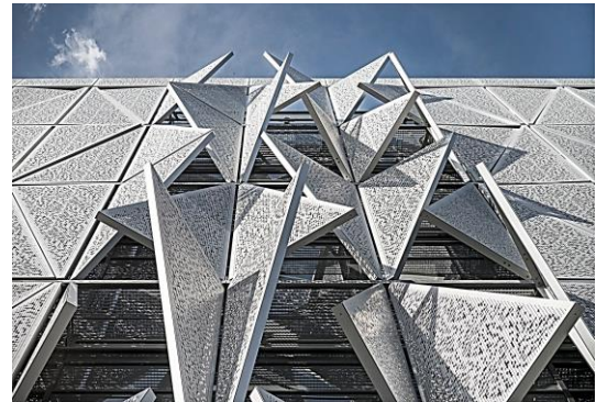
شكل (14) واجهة Koldinig Campus-الدنمارك، المرجع /https://www.archdaily.com
