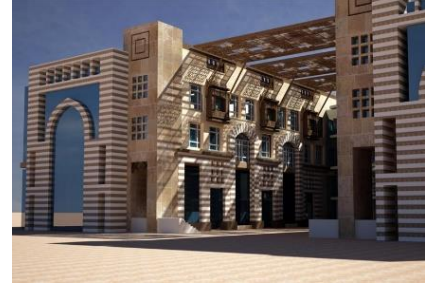
شكل 22. استخدام الملاقف والمشربيات في الواجهات.
